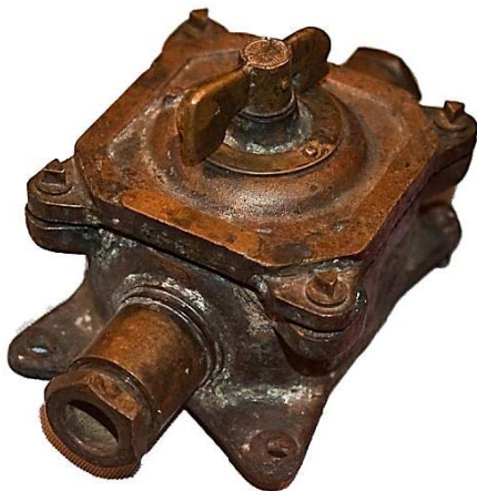
Rys. 9. Przedwojenny łącznik w wykonaniu ognioszczelnym
